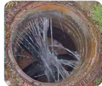
Grundwassereintritt im undichten Kanalschacht.
